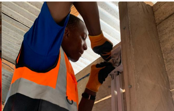
Figura A5.10. Instalación de las cajas de derivación. Fuente: elaboración propia.
