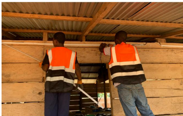
Figura A5.13. Instalación de cableado. Fuente: elaboración propia.
