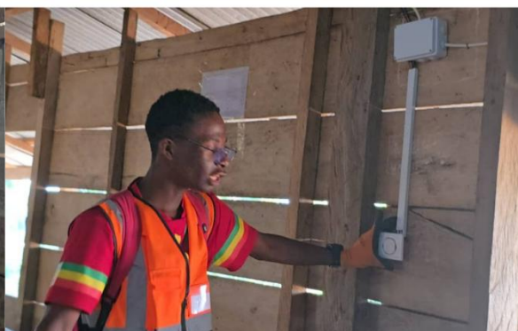
Figura A5.12. Instalación de interruptores. Fuente: elaboración propia.
