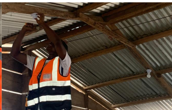
Figura A5.16. Instalación de luminarias. Fuente: elaboración propia.
