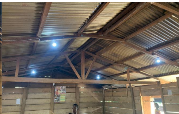
Figura A5.18. Iluminación central. Fuente: elaboración propia.
