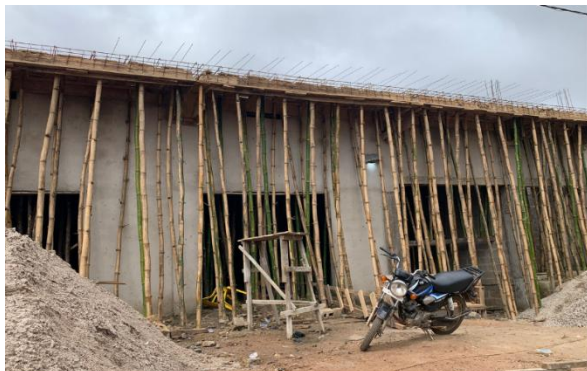
Figura A5.33. Andamios en la ciudad de N'Zérékoré. Fuente: elaboración propia.
