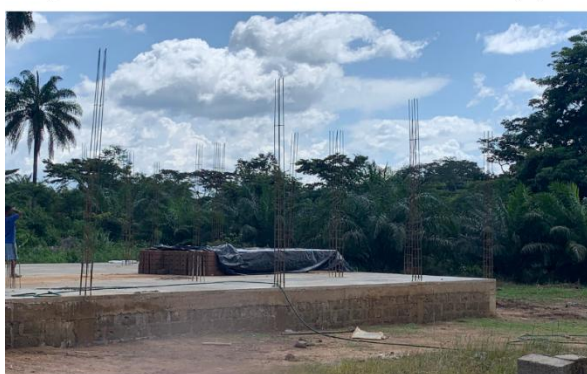
Figura A5.35. Progreso de nuevas construcciones del colegio. Fuente: elaboración propia.
