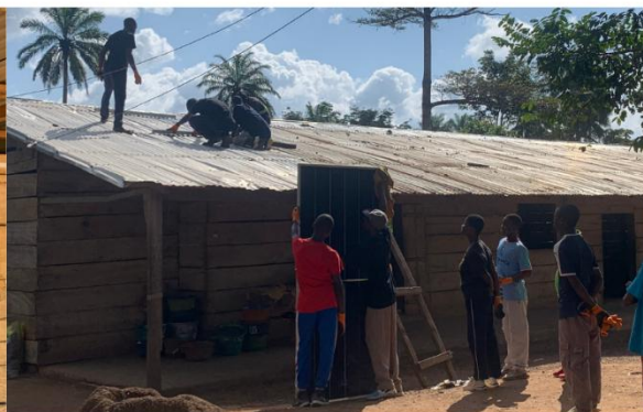
Figura A5.14. Desmontaje y montaje de panel fotovoltaico. Fuente: elaboración propia.
