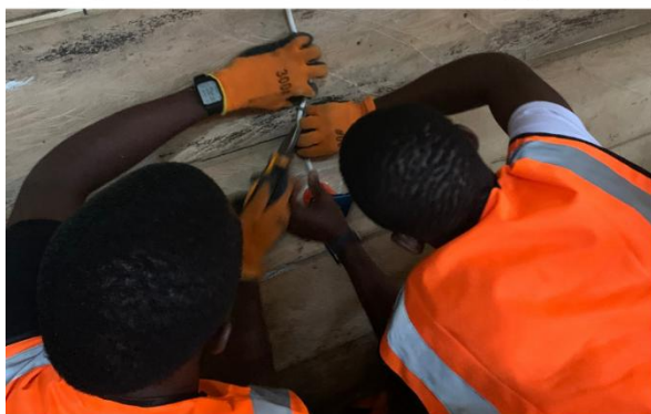
Figura A5.15. Instalación de toma de corriente. Fuente: elaboración propia.
